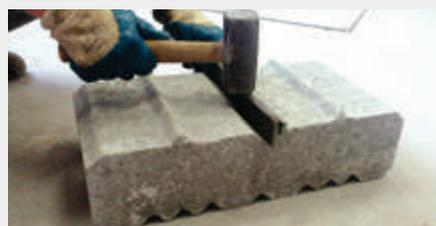
**2.** In die obere mittlere Nut über die gesamte Länge ein Flacheisen legen.
