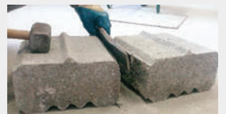
**3.** Durch einen kräftigen Schlag mit einem Hammer auf das Flacheisen wird der Stein gespalten.
