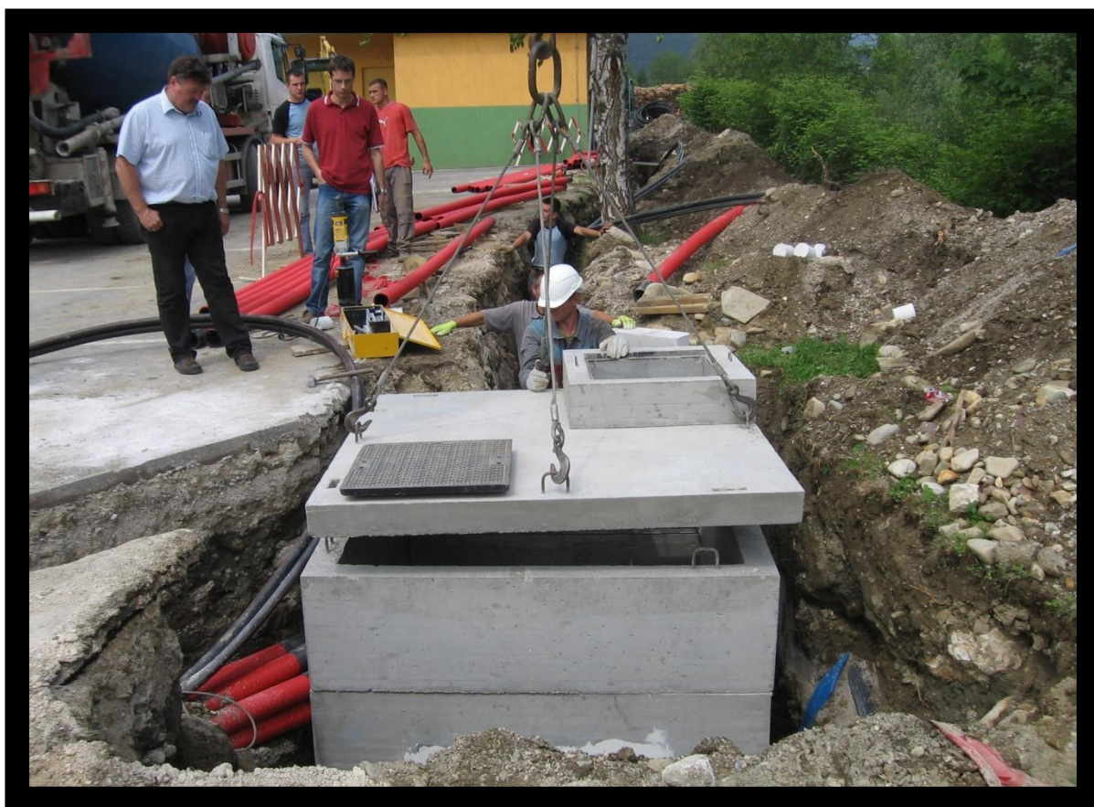
Slika 4; dvig in prenos montažnega elementa prototipa AB kablskega jaška
